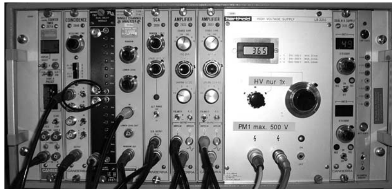
Abbildung 2.3: Alle verwendeten elektronischen Geräte im NIM Crade bis auf die weiteren Verzögerungsstufen, die in einem gesonderten Crade untergebracht sind. Von links nach rechts: Zähler, Koinzidenzeinheit, Verzögerungseinheit, SCA2, SCA1, Hauptverstärker 2, Hauptverstärker1, Spannungsversorgung 2, Spannungsversorgung 1.
