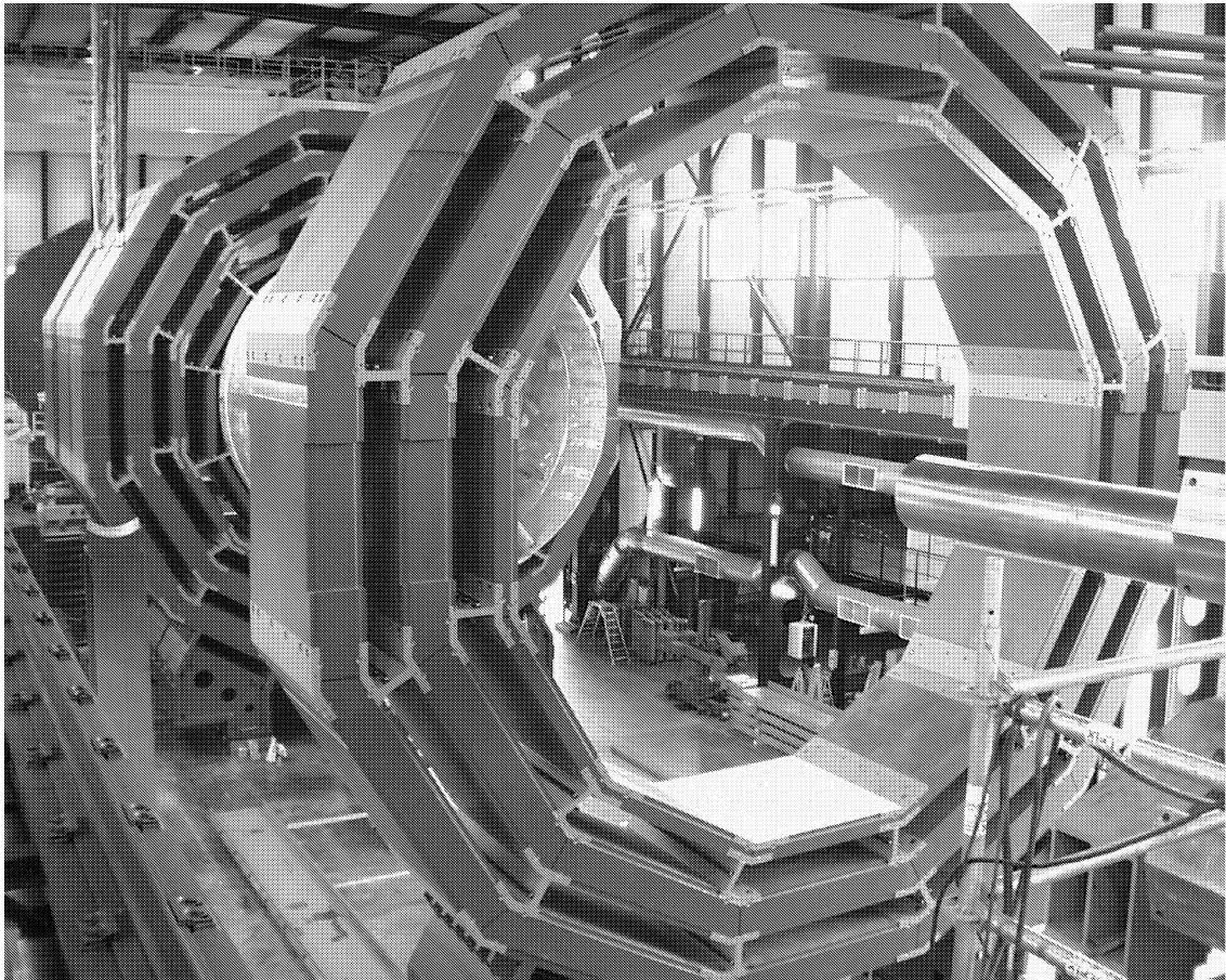
Abbildung 3.5: Aufbau der Rückflusseisen-Räder in der CMS-Halle [12]
